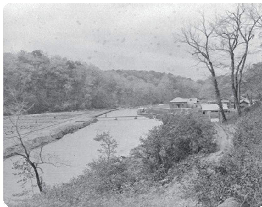
千歳川沿いのサケ孵化場（明治末） 北大附属図書館編『明治大正期の北海道：写真と目録』より
